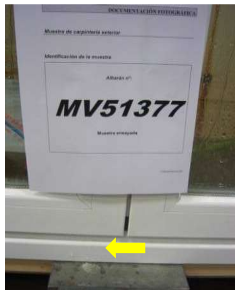
Zona filtración de agua
